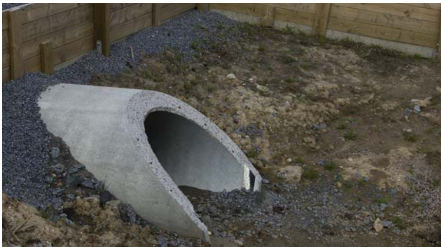
Figur 3. Den södra tunnelns södra mynning, vid damm #6.
