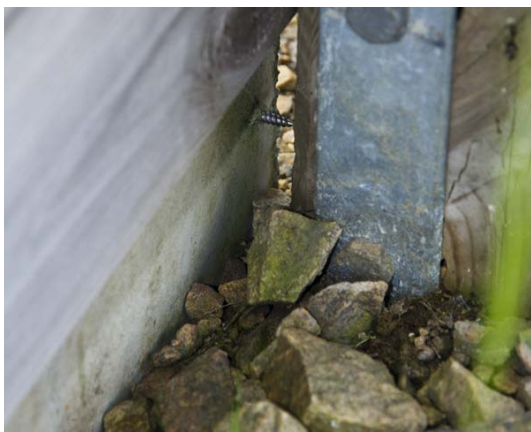
Figur 4. Bristande skruvförband.
