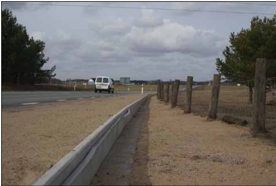
Figur 3. Av vägverket finansierad barriär som skall förhindra lökgrödor att passera över väg 19 vid reservatet i Tryde (Tomelilla kommun). Barriären sattes upp 2005. Bilden är tagen i april 2006 mor norr. Reservatet är beläget 100 m öster om vägen. Vid inventeringen 2004 i samband med lekvandringen noterade Loman (2005) 9 lökgrödor på vägen varav 6 trafikdödade. Under ett besök i augusti hittades fyra lökgrödor på vägen, varav två trafikdödade. Det spelade 210 hanar i reservatet 2004, och om alla djur på vägen vid lekvandringen var hanar så motsvarade det 5 % av populationen. Enligt Hels och Buchwald (2001) så kan en trafikmortalitet på 10 % märkbart reducera en populations storlek.
